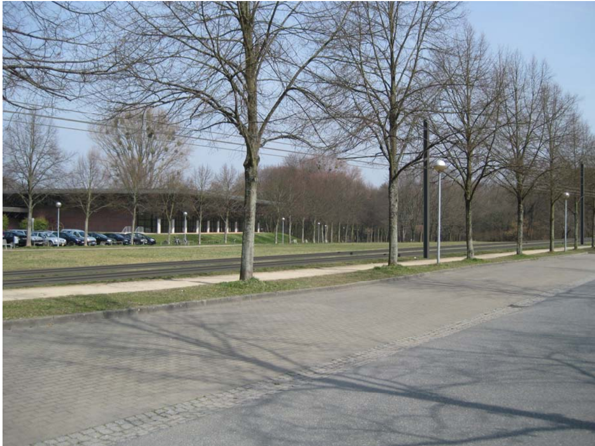
Abb. 1: Visualisierung der Trasse mit Fahrleitungsanlage im Bereich der Grünfläche und der Straßenbäume nördlich des Lichtwiesenweges
